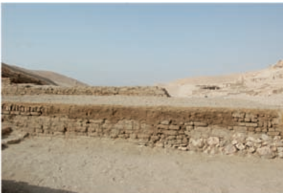
Fig. 52. Le nouveau toit installé sur la chapelle dite d'Opet a été recouvert des mêmes matériaux que ceux se trouvant sur l'ensemble du site.
