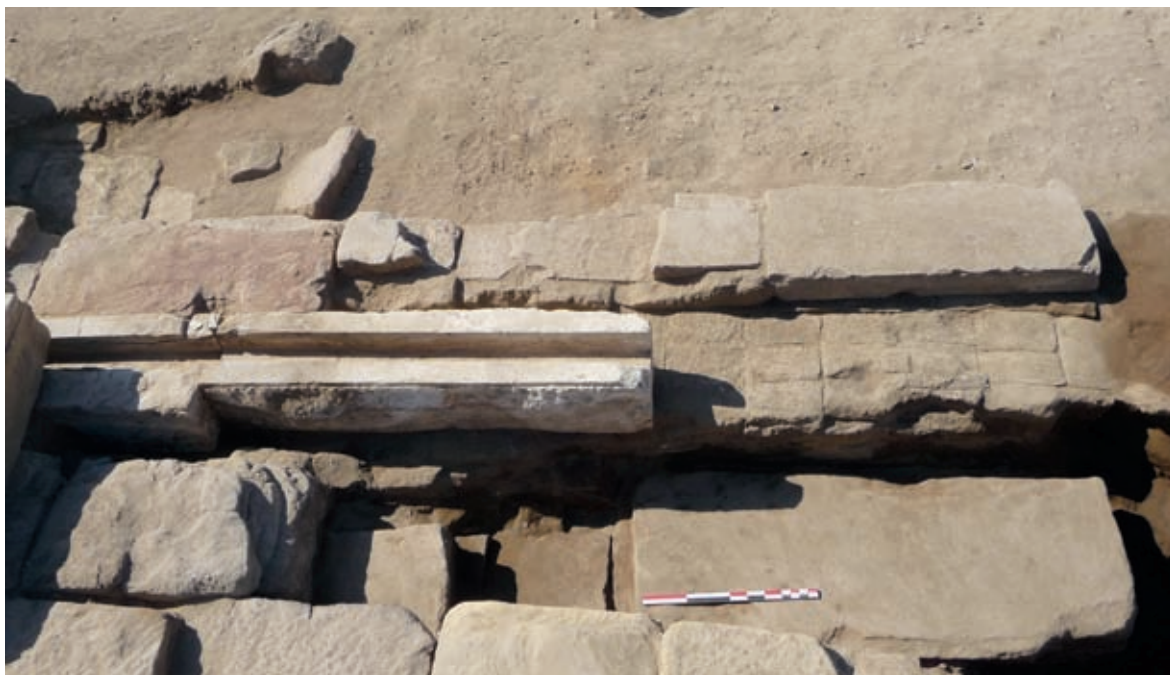
Fig. 70. La canalisation « copte » © Chr. Thiers.
