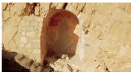
Fig. 54. La chapelle de la tombe TT 212 avant restauration.
