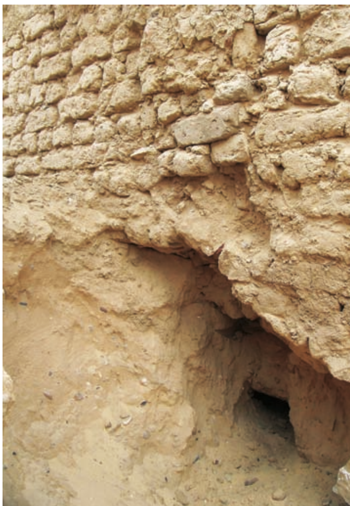
Fig. 98. La fondation du mur nord de TG 4, construit sur le sable avec l'une des trois cavités découvertes sous le mur.
