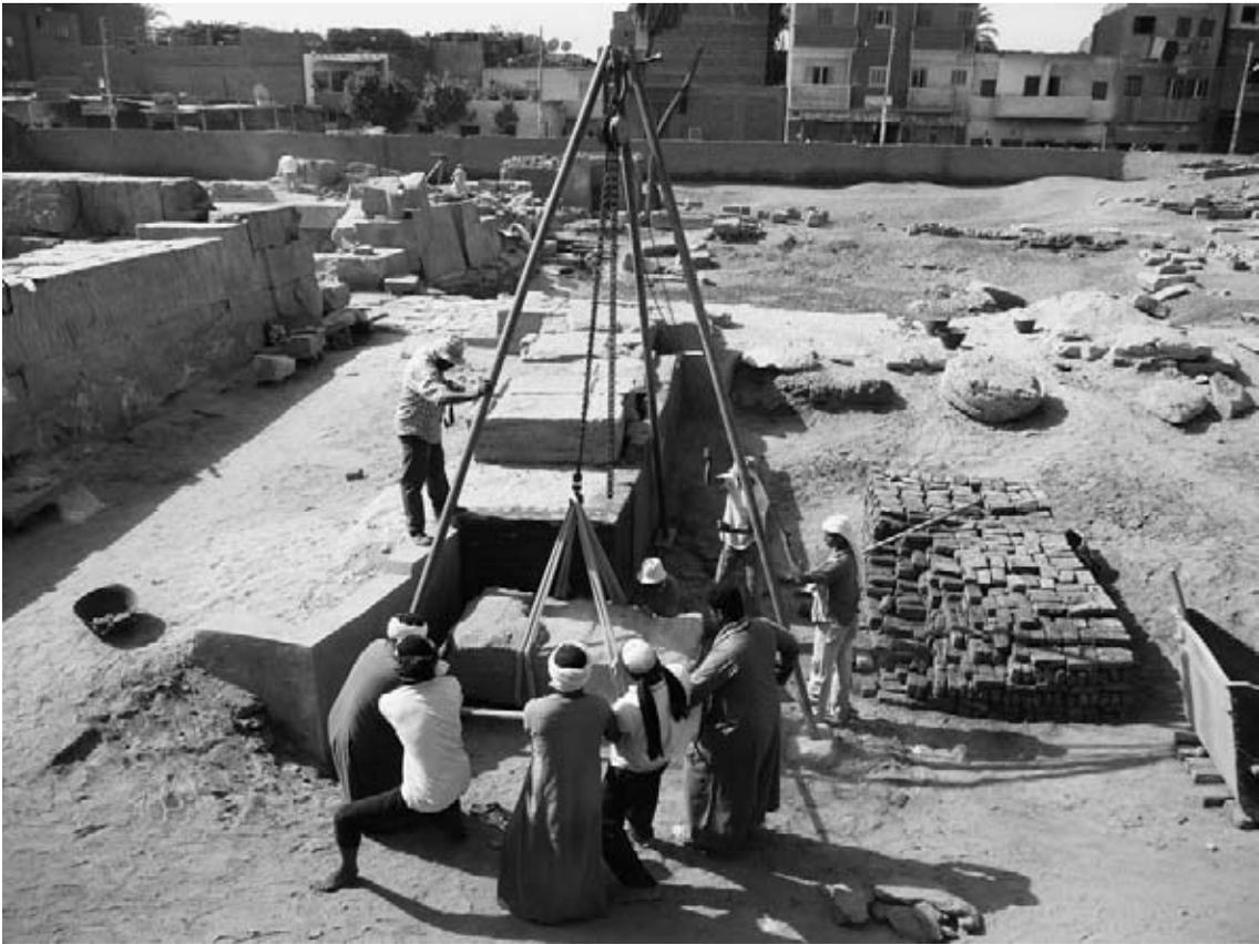
FIG. 36. Remontage d'un bloc de l'autel gréco-romain.
