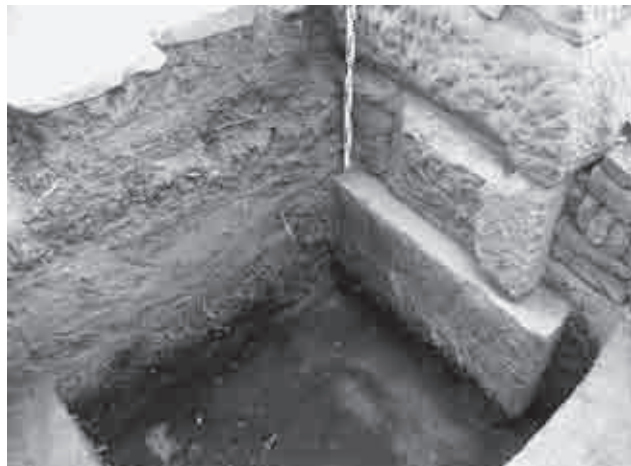
FIG. 25. Vue de la pierre de fondation de l'angle nord-est du pronaos et les deux premières assises de la maçonnerie avec leur bossage et la matière prévue pour le boudin d'angle.
