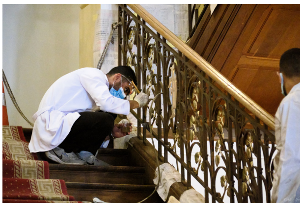
Fig. 7. Restauration des dorures du grand escalier d'honneur. © A. Bahgat/Ifao, 2025.
