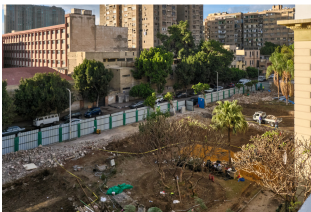
Fig. 6. Début des travaux de construction de la bibliothèque Sauneron, septembre 2025. © Ifao.
