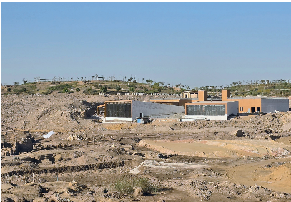
Fig. 13. Site archéologique de Fustat. Magasins en construction. © Abbès Zouache.
