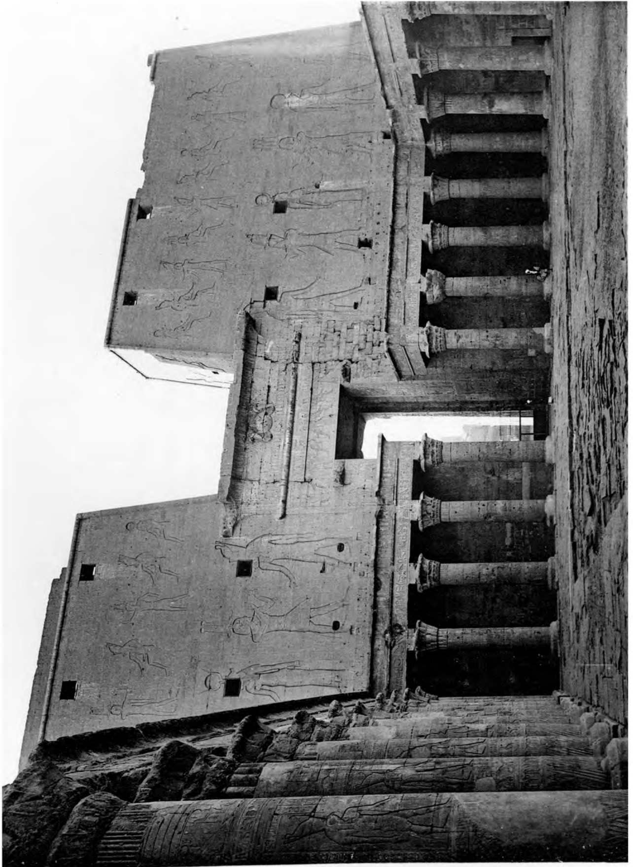
Cour et face nord du pylône.
