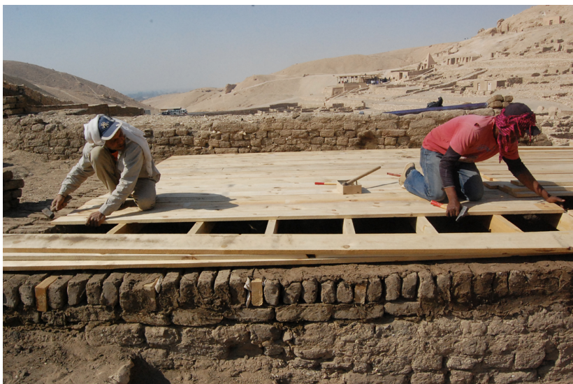
Restoration du plafond de la chapelle située contre le mur nord du village (campagne 2012).
