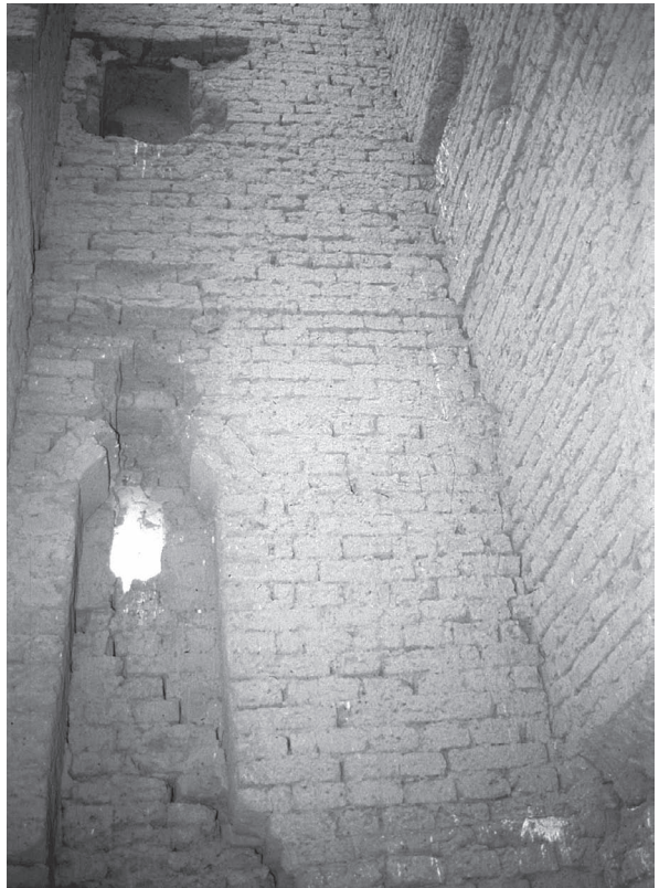
35. Taoun el-Hawa, vue intérieure (photo Reddé).
