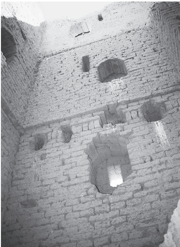
36. Taoun el-Hawa, vue intérieure (photo Reddé).
