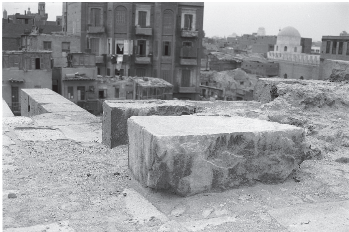
Fig. 16. Vue du bloc sur la plate-forme de Bab al-Nasr.
