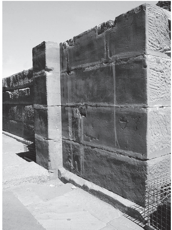
Fig. 6. Idem , vue de l'embrasure est avec des cavités de crampons en queues d'arondes apparaissant dans l'élévation ravalée lors de la restauration antique.
