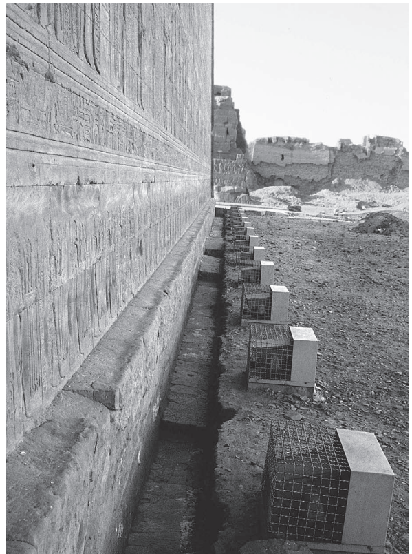
Fig. 4. Radier au pied de la façade ouest du naos.
