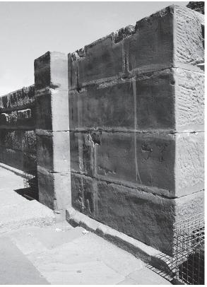
Fig. 6. Idem, vue de l'embrasure est avec des cavités de crampons en queues d'arondes apparaissant dans l'élévation ravalée lors de la restauration antique.
