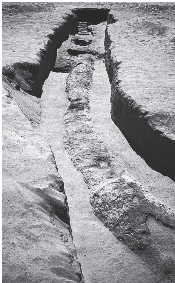
Fig. 50. La voûte partiellement effondrée de la branche MQ6.
