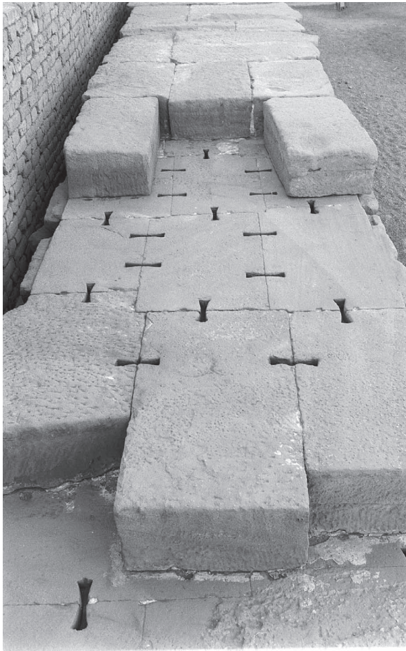
Fig. 1. Dendera, temple d'Hathor. Détail de l'agrafage d'un bloc sur le mur péribole en pierre (cliché Alain Lecler, Ifao).
