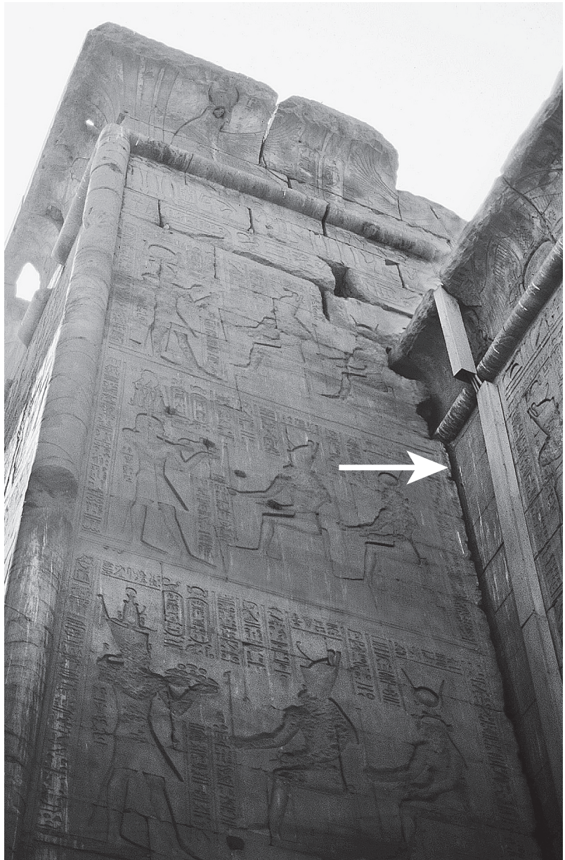
Fig. 11. Edfou, temple d'Horus. Altération du contact est naos/pronaos : la maçonnerie du pronaos s'écarte de plusieurs centimètres de celle du naos avec pour conséquence la fissuration de la corniche à l'aplomb.
