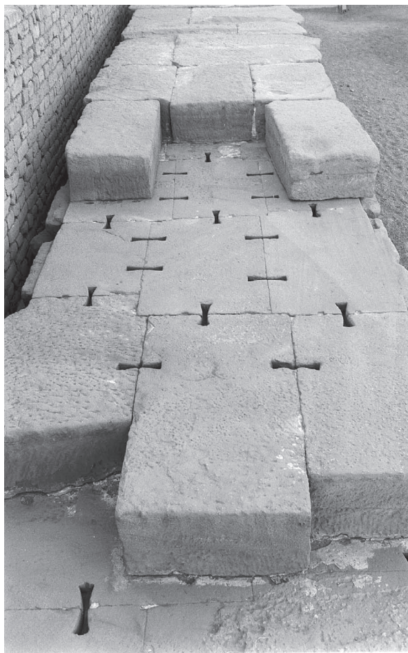
Fig. 1. Dendera, temple d'Hathor. Détail de l'agrafage d'un bloc sur le mur péribole en pierre (cliché Alain Leclerc, Ifao).
