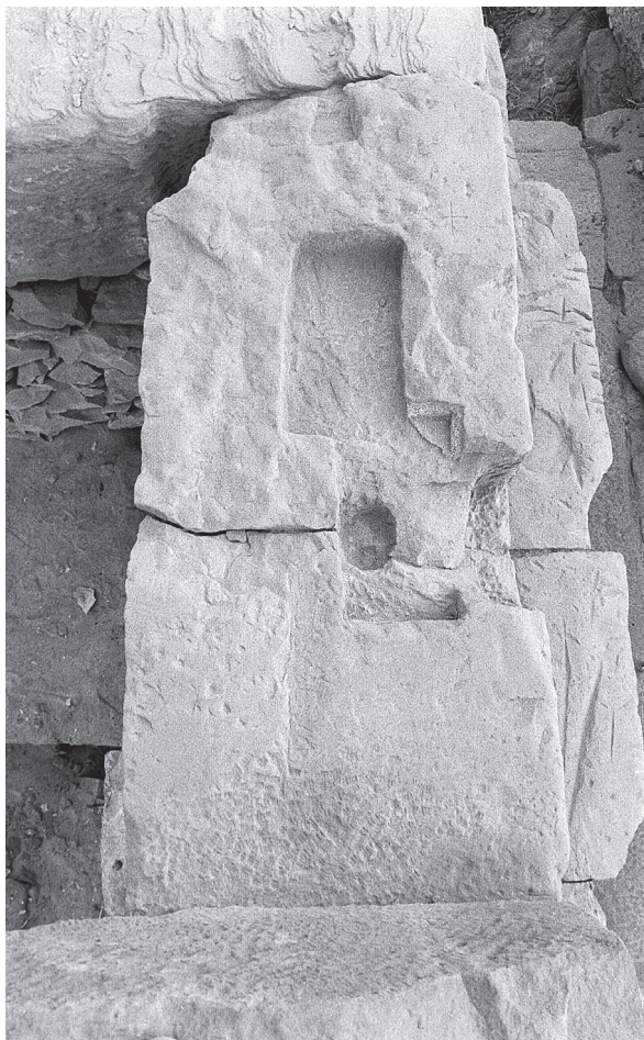
Photo 21. Bloc n° 16 (linteau). Réaménagement du logement de la contre-crapaudine.
