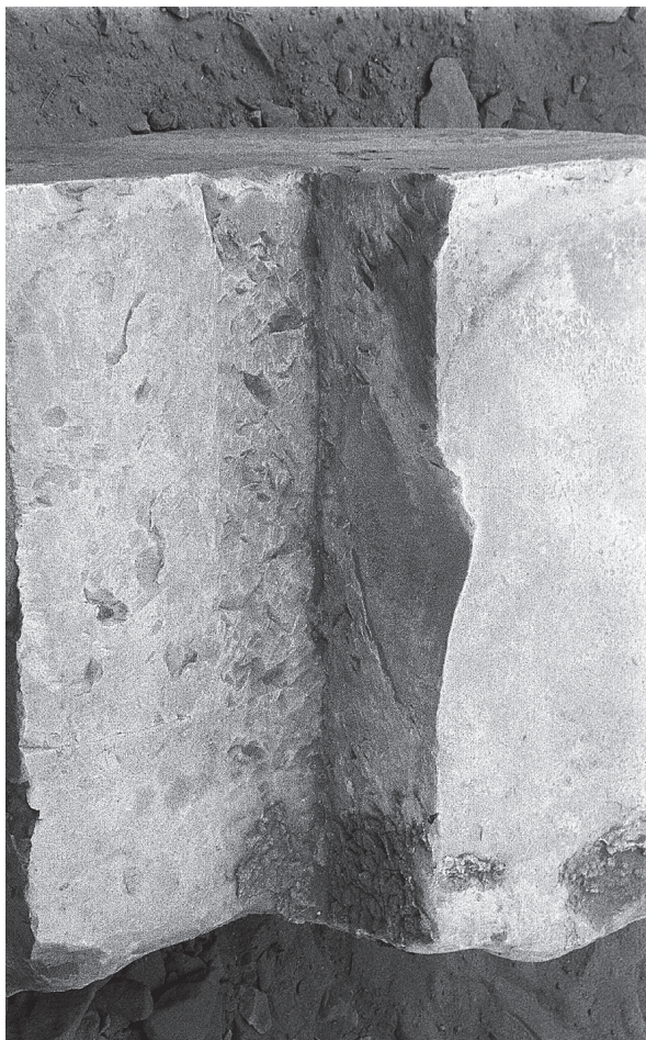
Photo 20. Bloc n° 14 : retaille de la feuillure verticale.
