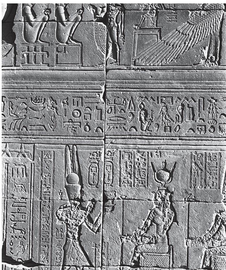
Fig. 35. Conséquences des tassements différentiels : décalage dans la continuité horizontale de l'épigraphie (cliché A. Lecler).
