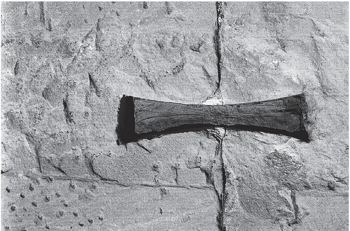
Fig. 7. Dendera, temple d'Hathor, crampon en forme de double queue d'aronde de la corniche démantelée.
