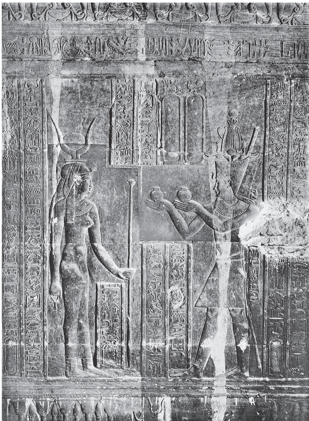
Fig. 13. Dendera, temple d'Hathor, exemple de coulures du mortier de pose des dalles dans la crypte est n° 2 (d'après É. Chassinat, Le temple de Dendara V/2, Le Caire, 1947, pl. 387).
