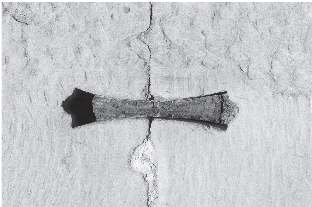
Fig. 8. Dendera, temple d'Hathor, crampon en forme de double queue d'aronde du mur d'enceinte en pierres.
