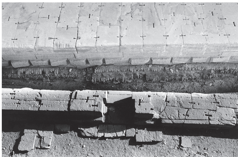
Fig. 2. Dendera, fondation du mur d'enceinte de pierre du temple d'Hathor avec le mur caisson en briques.
