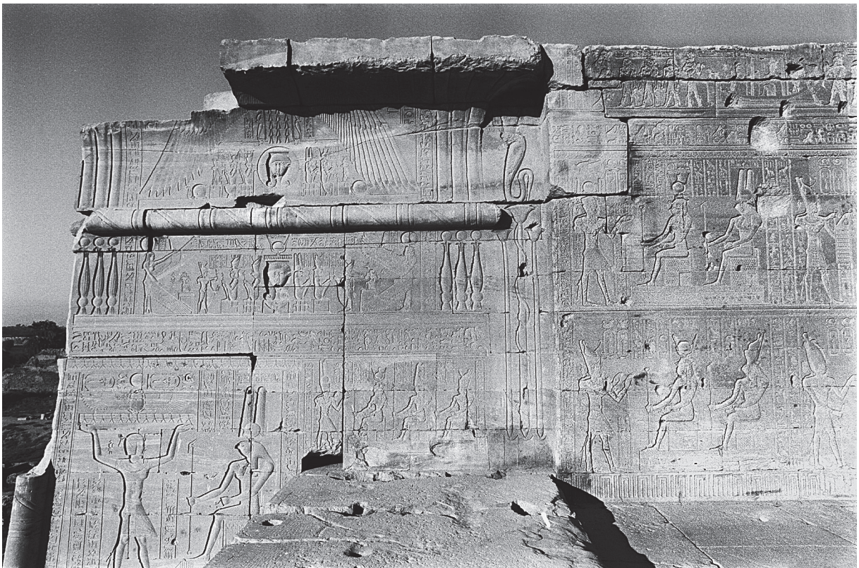
Fig. 33. Couronnement de l'articulation ouest entre les maçonneries du pronaos et du naos.
