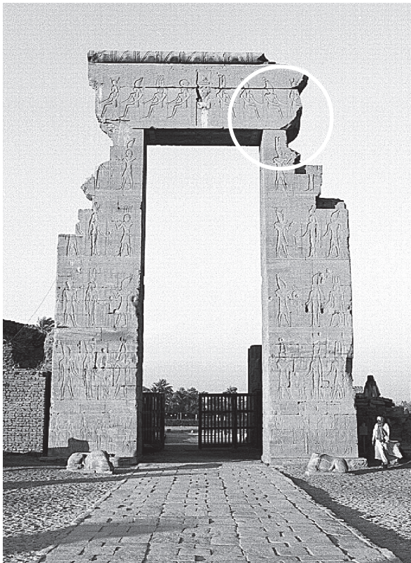
Fig. 25. Dendera, porte nord d'accès au sanctuaire d'Hathor, élévation sud.
