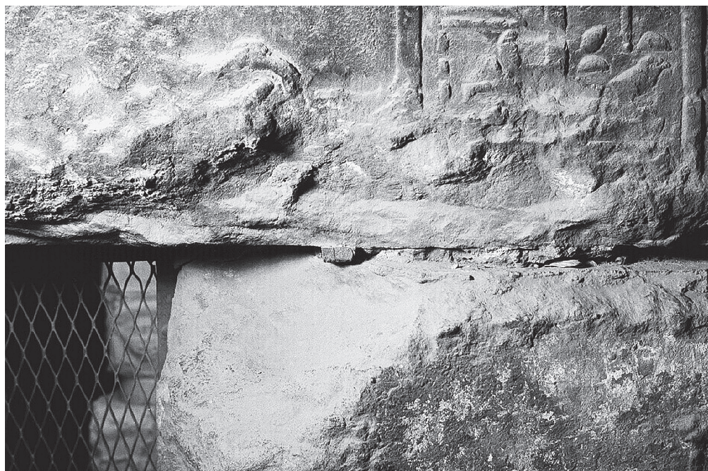
Fig. 23. Dendera, temple d'Hathor, atelier des orfèvres, détail d'une cale de bois dans le joint sous le linteau.
