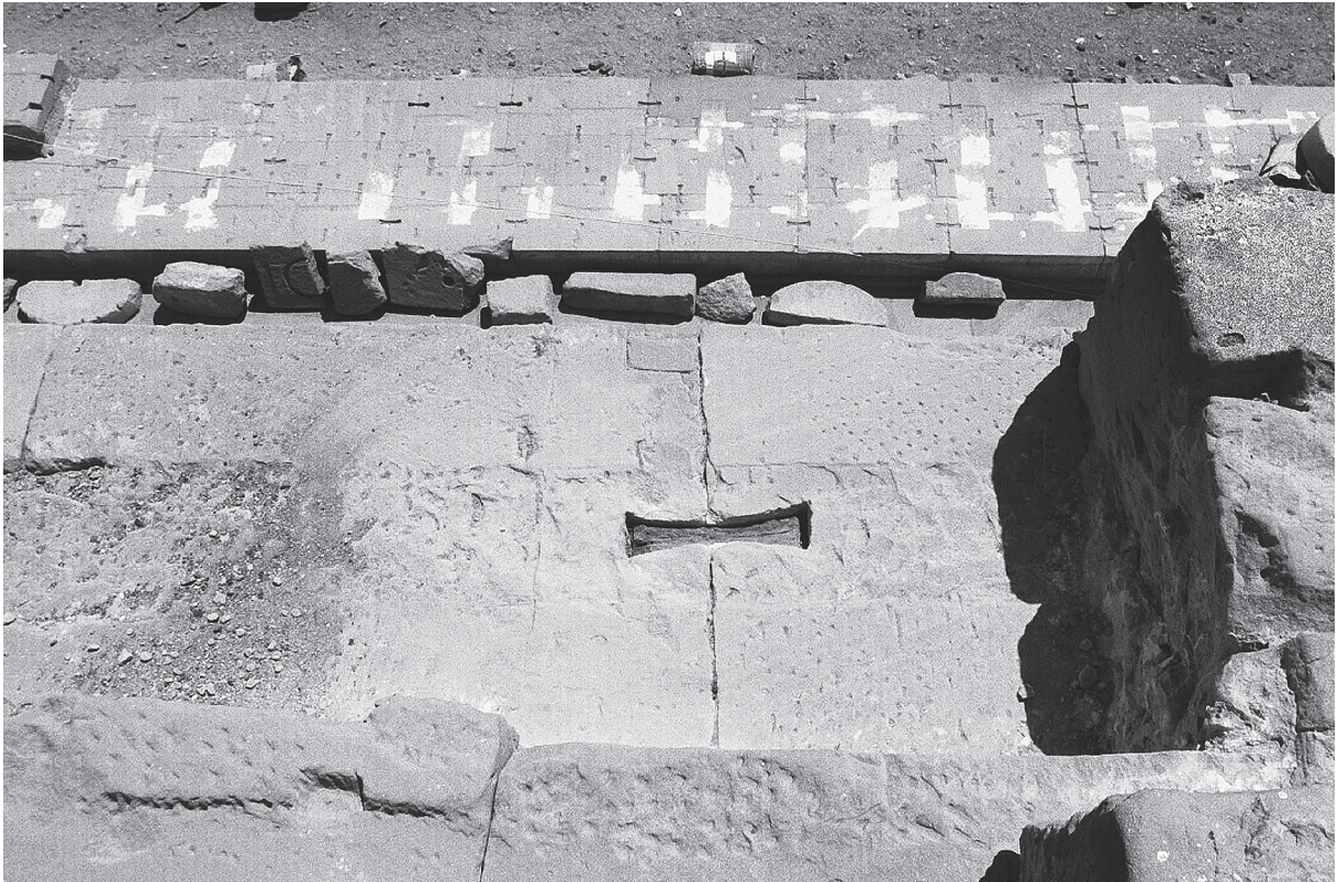
Fig. 6. Dendera, temple d'Hathor, maçonnerie démantelée de la corniche du naos avec un crampon de bois en place.
