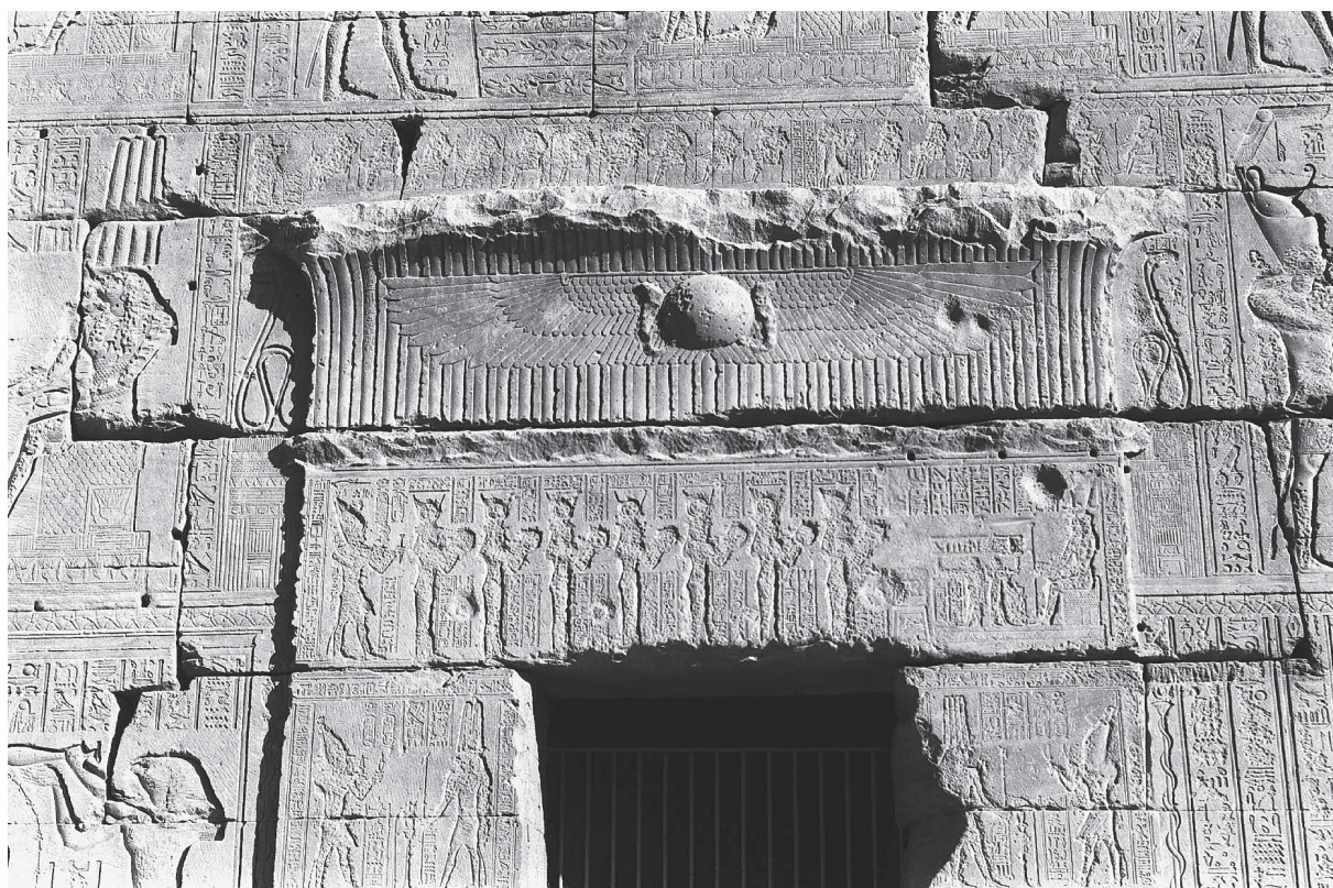
Fig. 20. Détail de la fig. 19.
