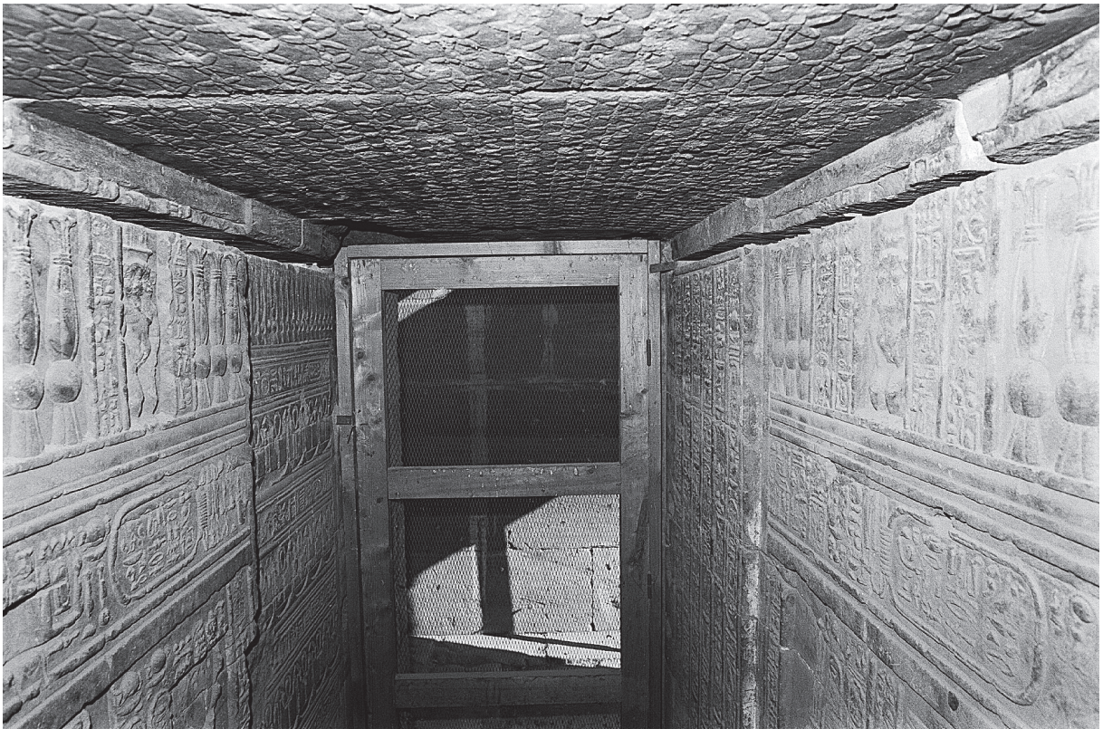
Fig. 16. Dendera, mammisi romain, passage entre la salle des offrandes et le couloir au portique nord, détail du joint ouvert entre les dalles de plafond et les murs.
