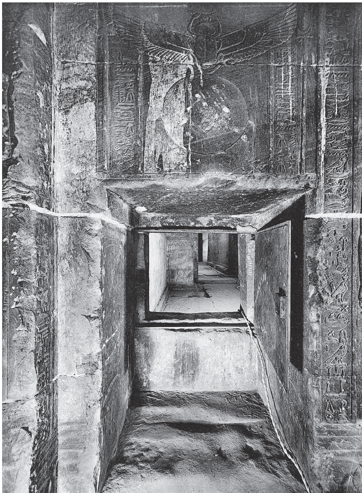
Fig. 22. Dendera, temple d'Hathor, exemple de joint épais entre le linteau et les montants de l'entrée de la crypte est n° 2. (d'après É. Chassinat, Le temple de Dendara V/2 , Le Caire, 1947, p. 360).
