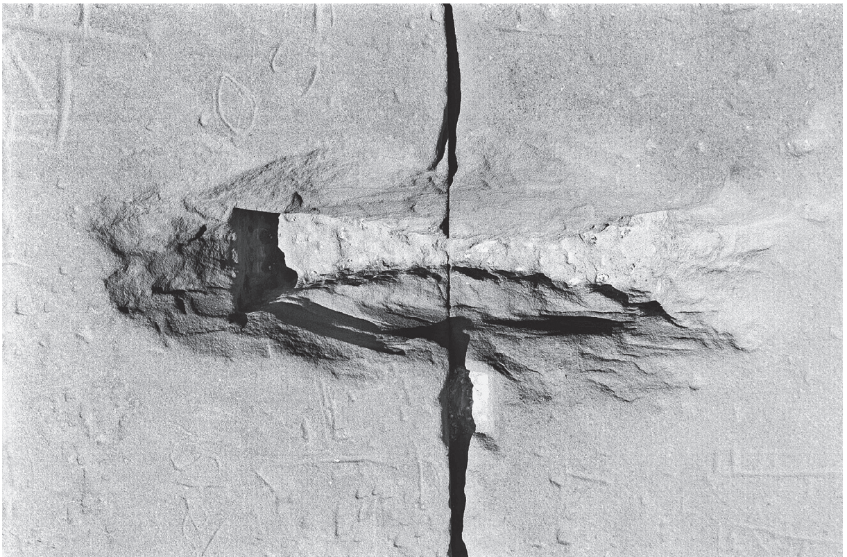
Fig. 9. Dendera, temple d'Hathor, corniche du pronaos, forme de mortaise détruite par l'effort de récupération d'un crampon métallique.
