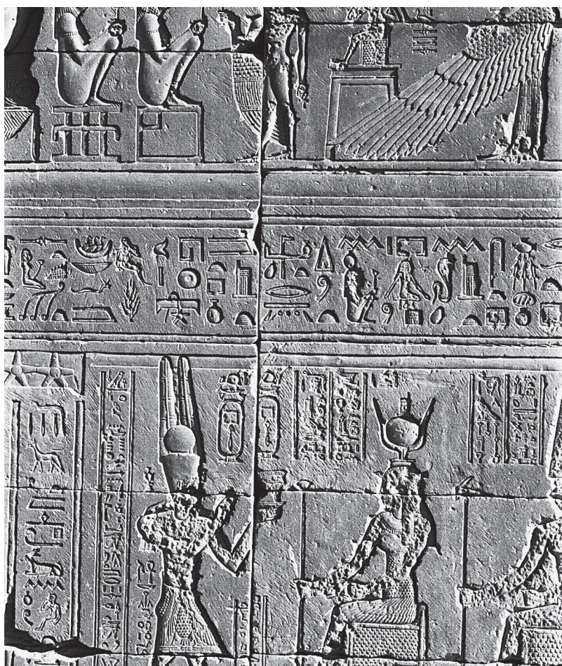
Fig. 35. Conséquences des tassements différentiels : décalage dans la continuité horizontale de l'épigraphie (cliché A. Lecler).
