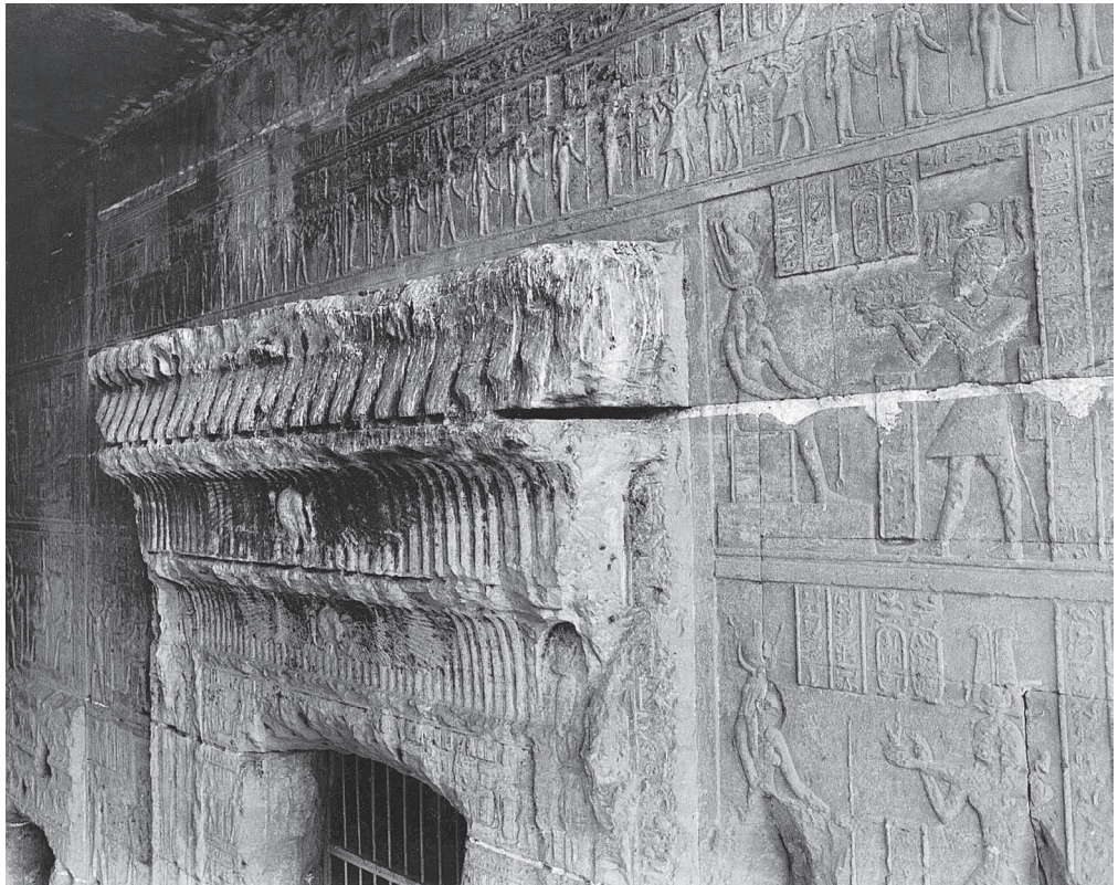
Fig. 24. Dendera, temple d'Isis, détail du joint entre les linteaux au-dessus de l'entrée dans la chapelle principale.
