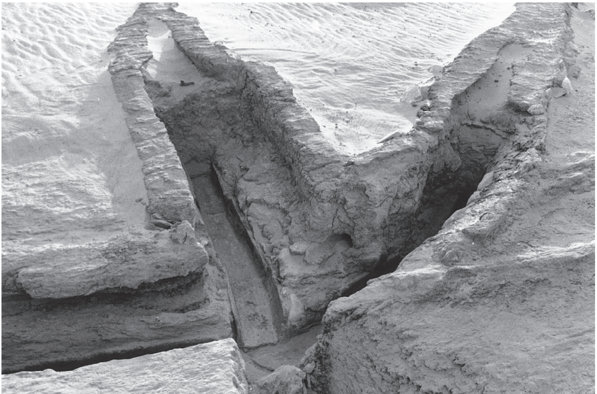
Fig. 77. Le répartiteur de la qanât Q-2.
