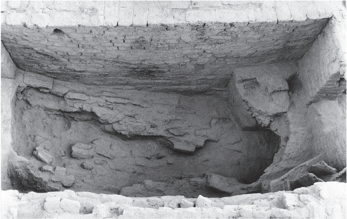
Fig. 7. La chapelle F. À l'extrême droite : restes du mobilier de la chapelle. Au centre : voûte effondrée du « caveau ».
