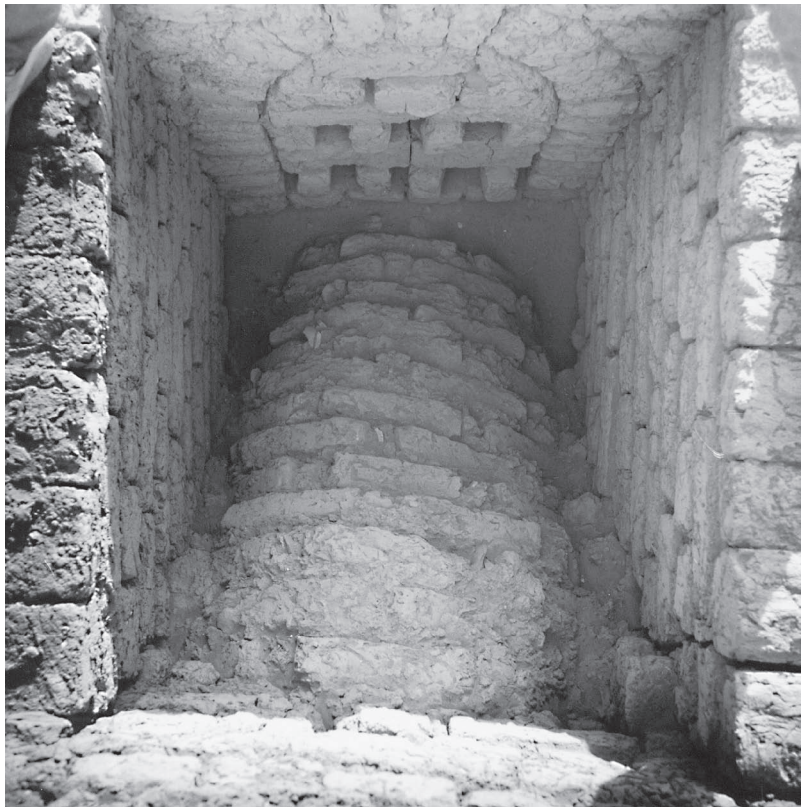
Fig. 18. Complexe de la tombe sud 1 : extrados de la voûte de l'escalier.
