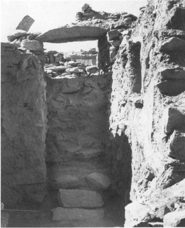
▽ Fig. 3. Fort.SE.Corner. Le passage IX. Chutes de pierre sur les premiers niveaux.
