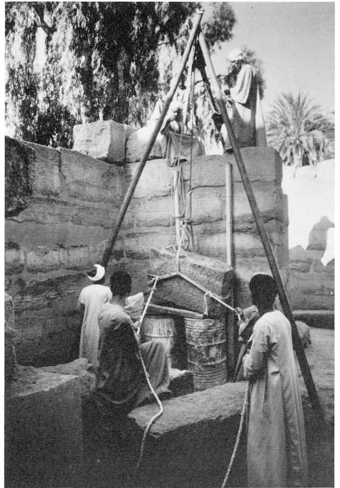
➤ a. remise en place d'un bloc au moyen de la chèvre.
