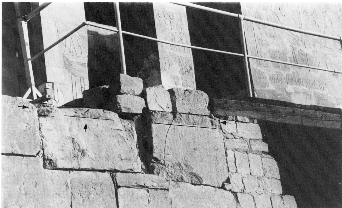
▽ Fig. 5. Vestiges du bord est de la deuxième terrasse. Le tore horizontal a été arasé lors de la construction de la troisième terrasse.
