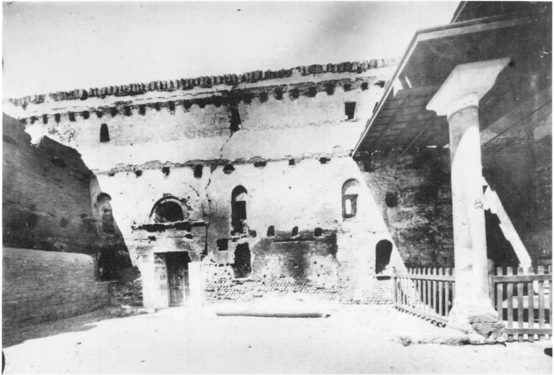
Fig. 2. Le mur nord avant la construction du mur tardif.
