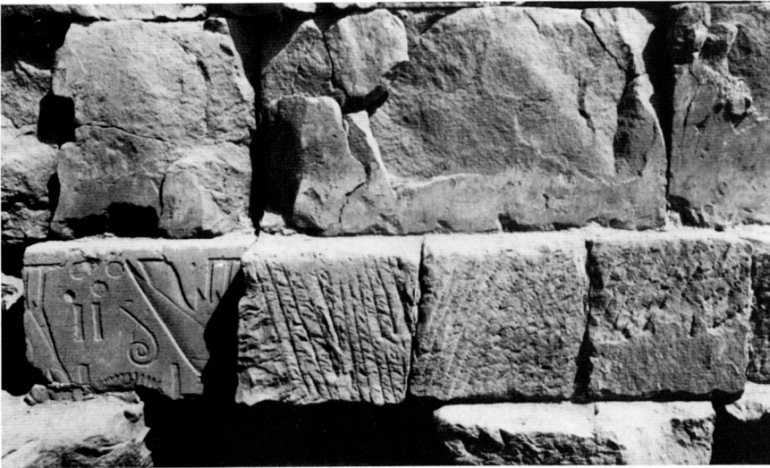
◁ A. Blocs bruts de carrière voisinant avec les remplois d'Aménophis III dans la reprise des fondation du mur est.
