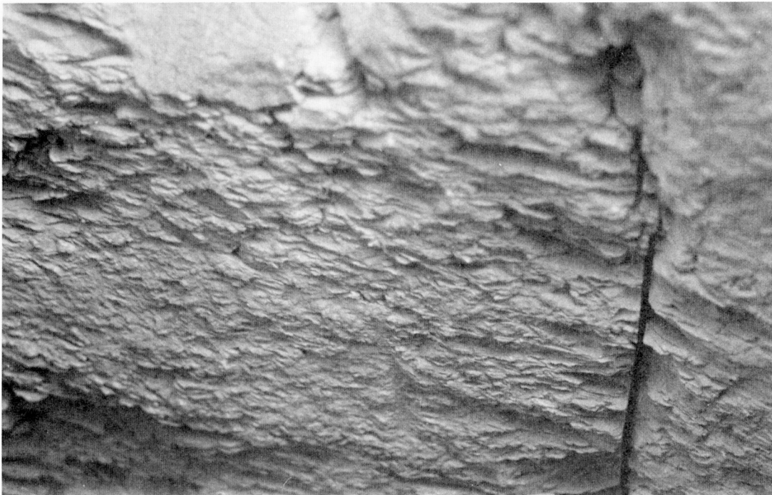
Fig. 7. — Détail du travail de taille.
