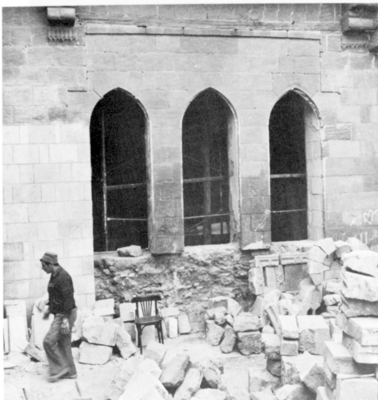
B. — Démontage des ouvertures du salon pour restitution de l'ouverture d'origine.
