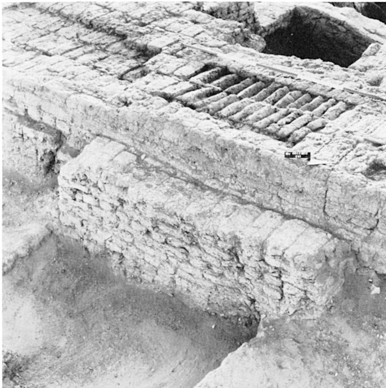
B. — Enceinte Est : au premier plan, le mur oriental du puits. Au second plan, deux alignements de briques appareillés sur une arête (cliché J.-F. Gout).
