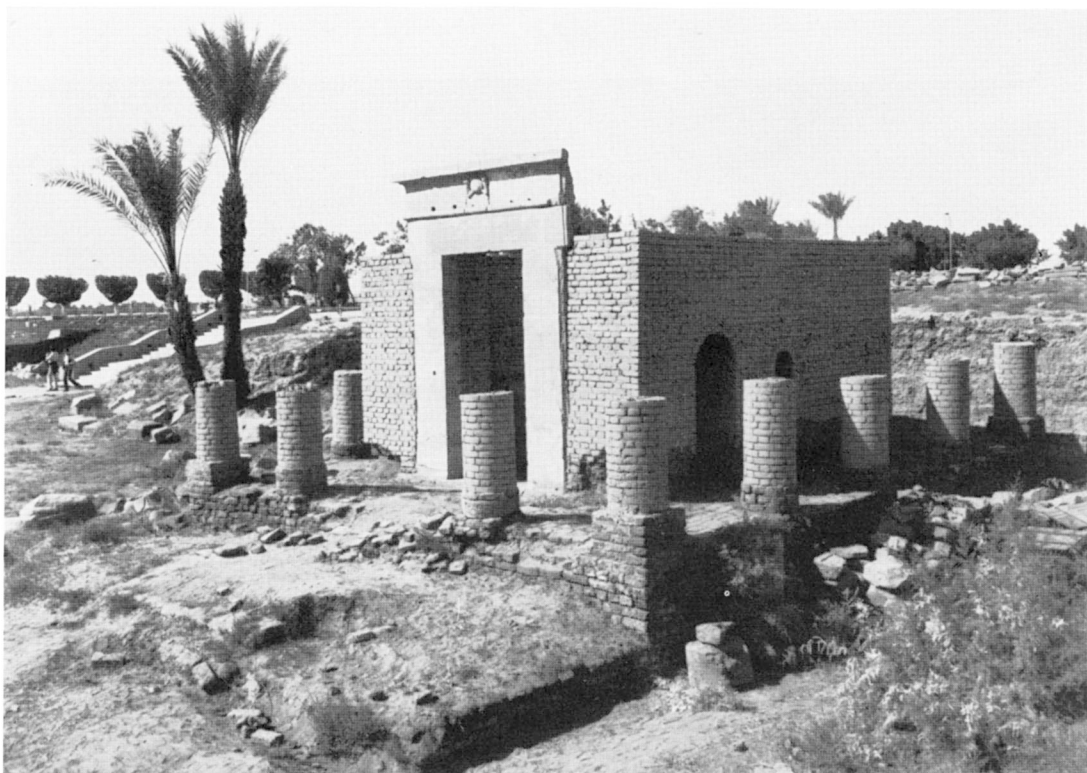
A. — Aspect général du monument vu de l'Est. La partie supérieure des murs de briques crues est restaurée (photo. A. Bellod).
