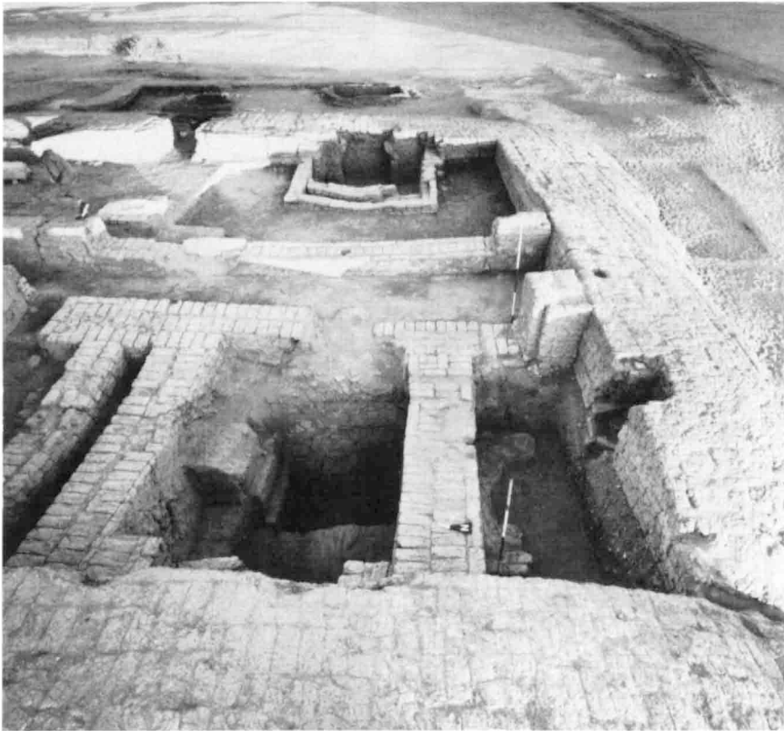
A. — Dépose des superstructures du secteur méridional. Vue en direction de l'Est (Cliché J.-F. Gout).
