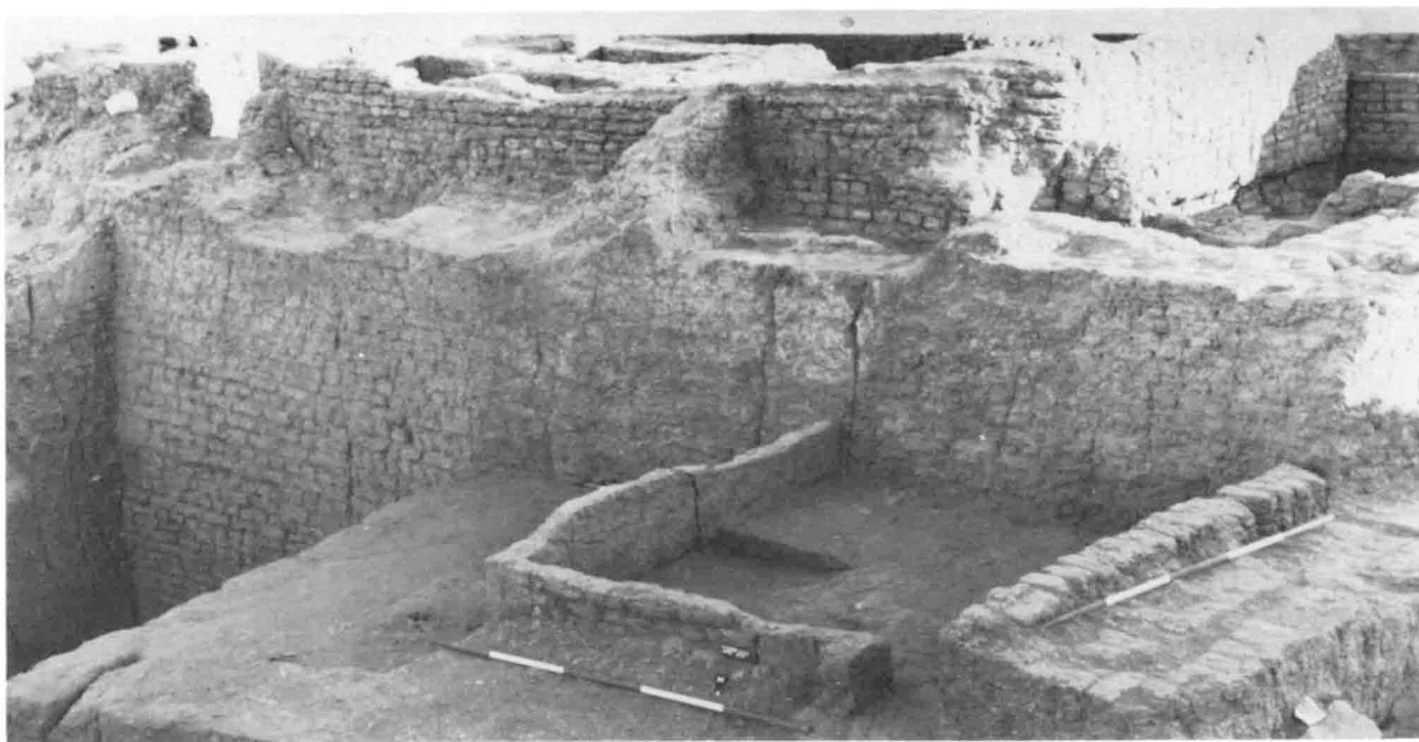
A. — « Maison des ouvriers », Phase III a. Vue du nord-ouest.
