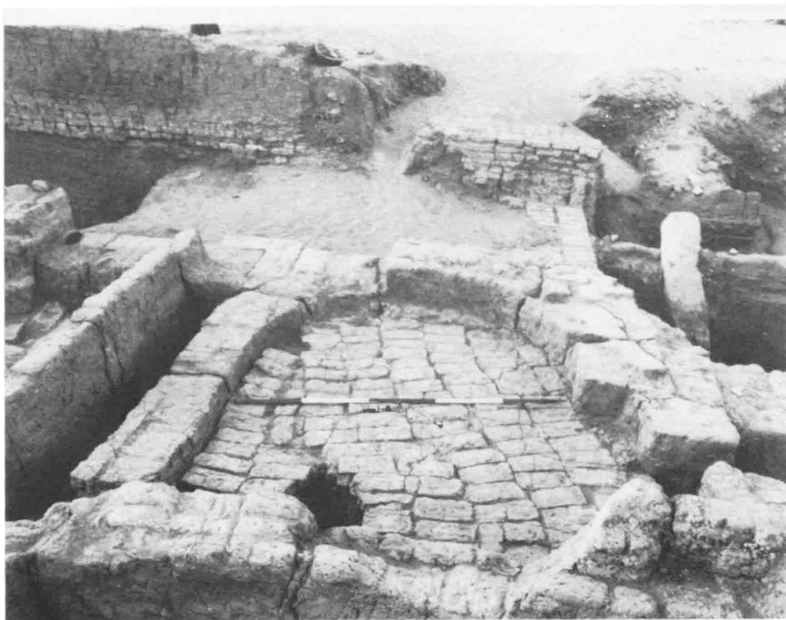
B. — Phase III a : radier de briques remplissant la chambre D de Phase II. Vue du nord.
