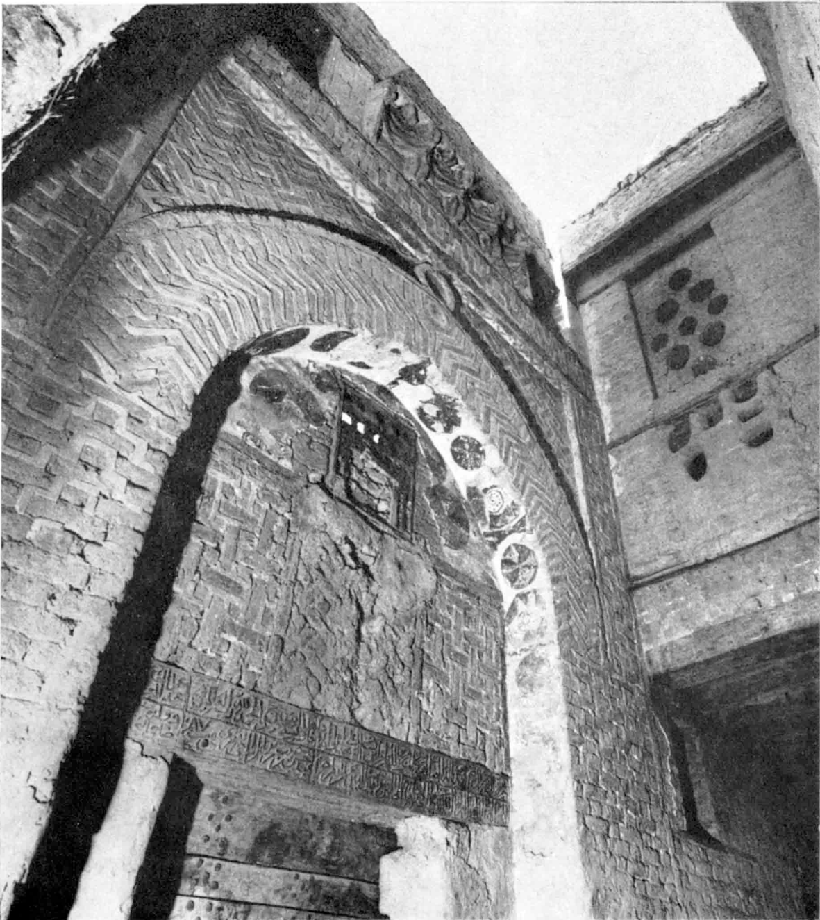
Dakhleh, El-Qasr. Porte à linteau sculpté.
