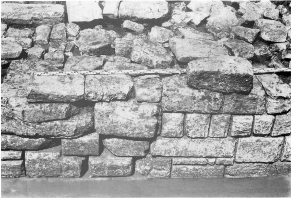
A. — Tanis, Lac sacré — Rive Ouest : parement de l'escalier. Vue de l'Est (Cliché Y. Gourlay).
