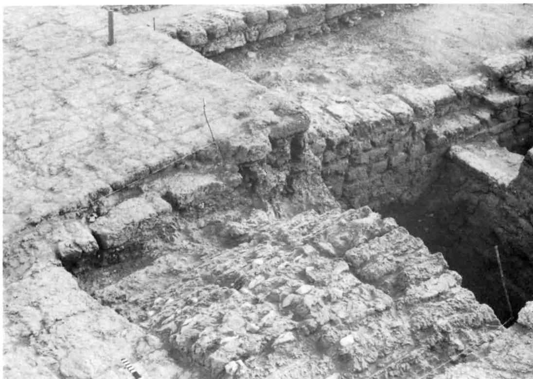
B. — Mastaba V : mur Est, dépose des assises de briques sur la voûte (Cliché J.-F. Gout).
