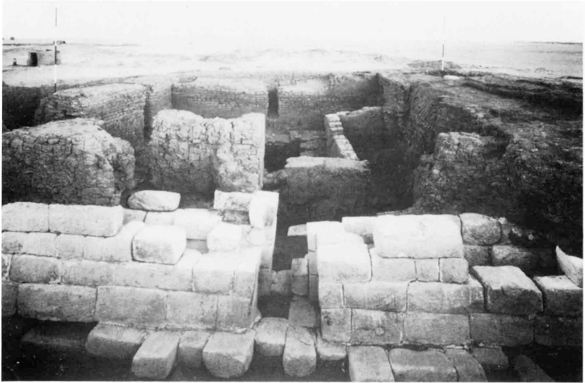
A. — Mastaba n° 3, vue de l'Ouest.
