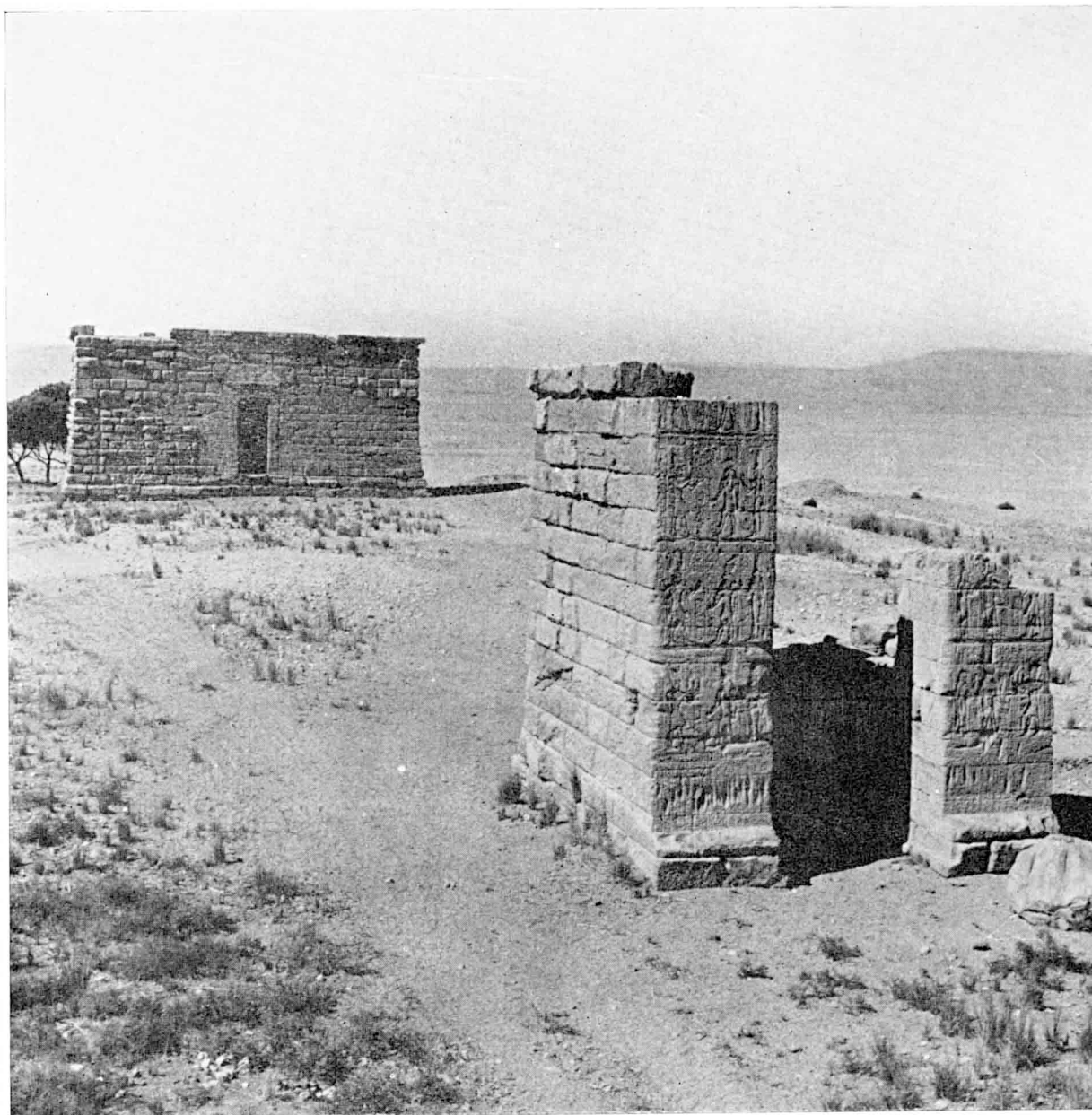
Vue générale du temple, de la cour et du propylône (cliché J.-F. Gout).
