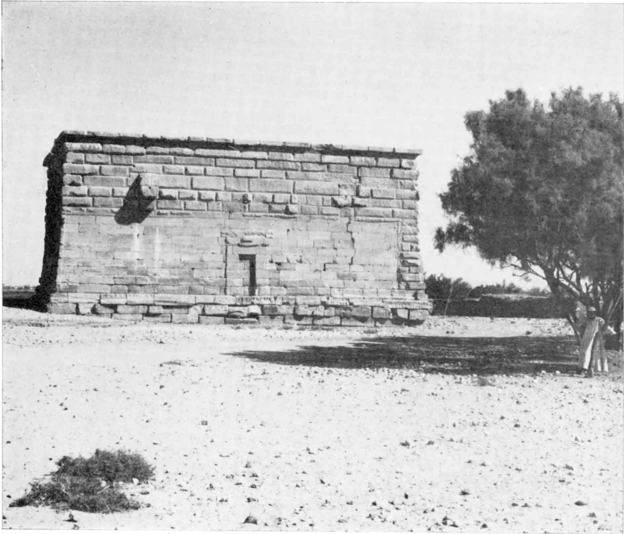
Vue de l'arrière du temple avec la niche (cliché J. Guill).
