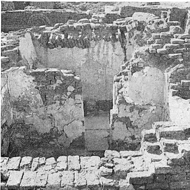
32. Caldarium (V), mur sud avec l'empreinte du triangle sphérique de la coupole.
