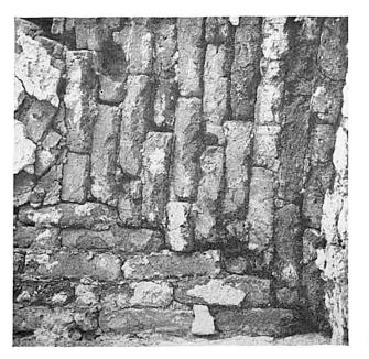
22. Tepidarium (III), coupole vue de dessous, détail de l'assemblage des briques.
