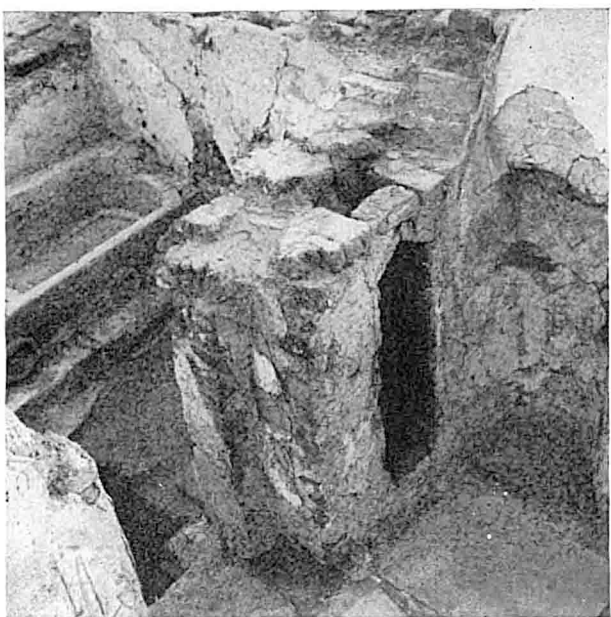
24. Laconicum (IV), angle nord-est, niche, gaine d'air chaud démunie de son briquetage et porte du caldarium.
