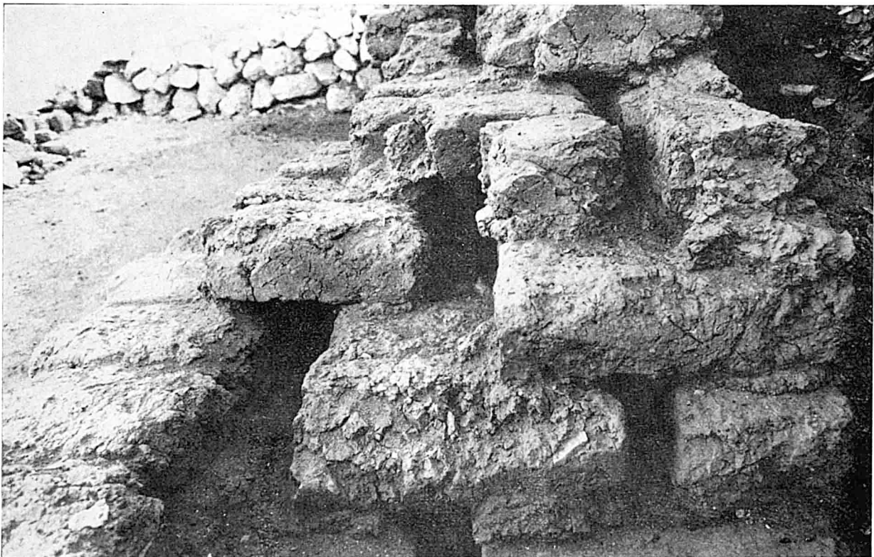
B. — Enceinte de Thoutmosis I er : détail de la maçonnerie.
