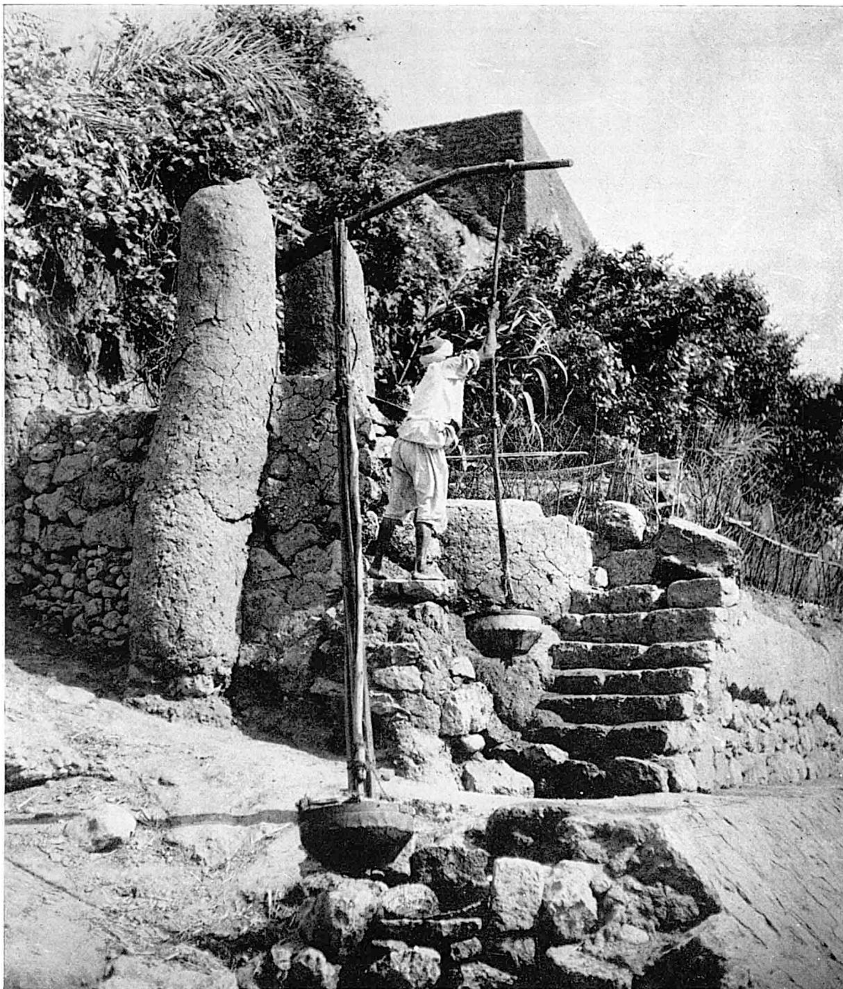
§ 274.— Type de chadouf utilisé à Mari Girgis (cliché Henry Gad Nessim).
