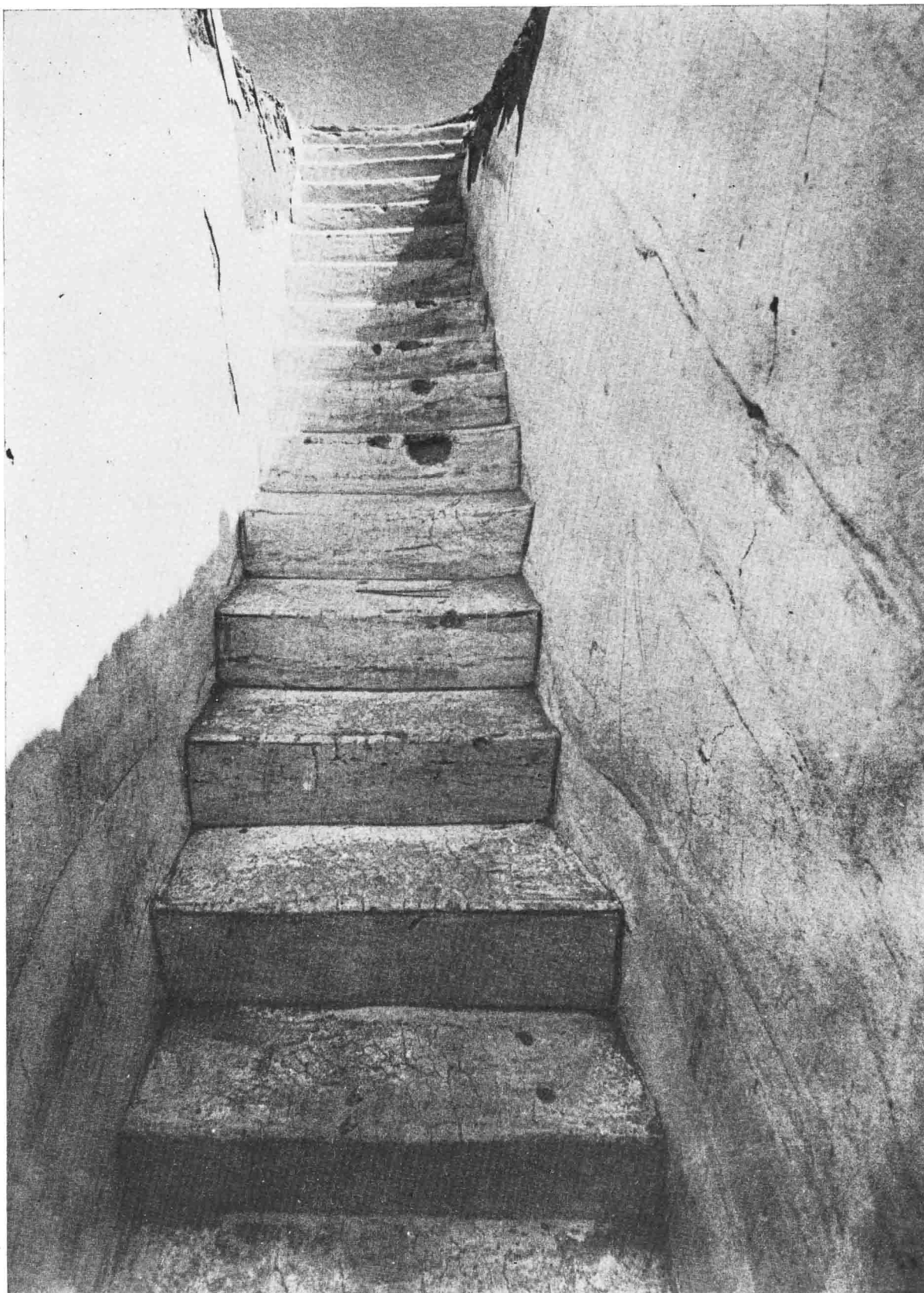
DÉSERT D'ESNA : L'escalier d'accès à l'ermitage n° 4.
