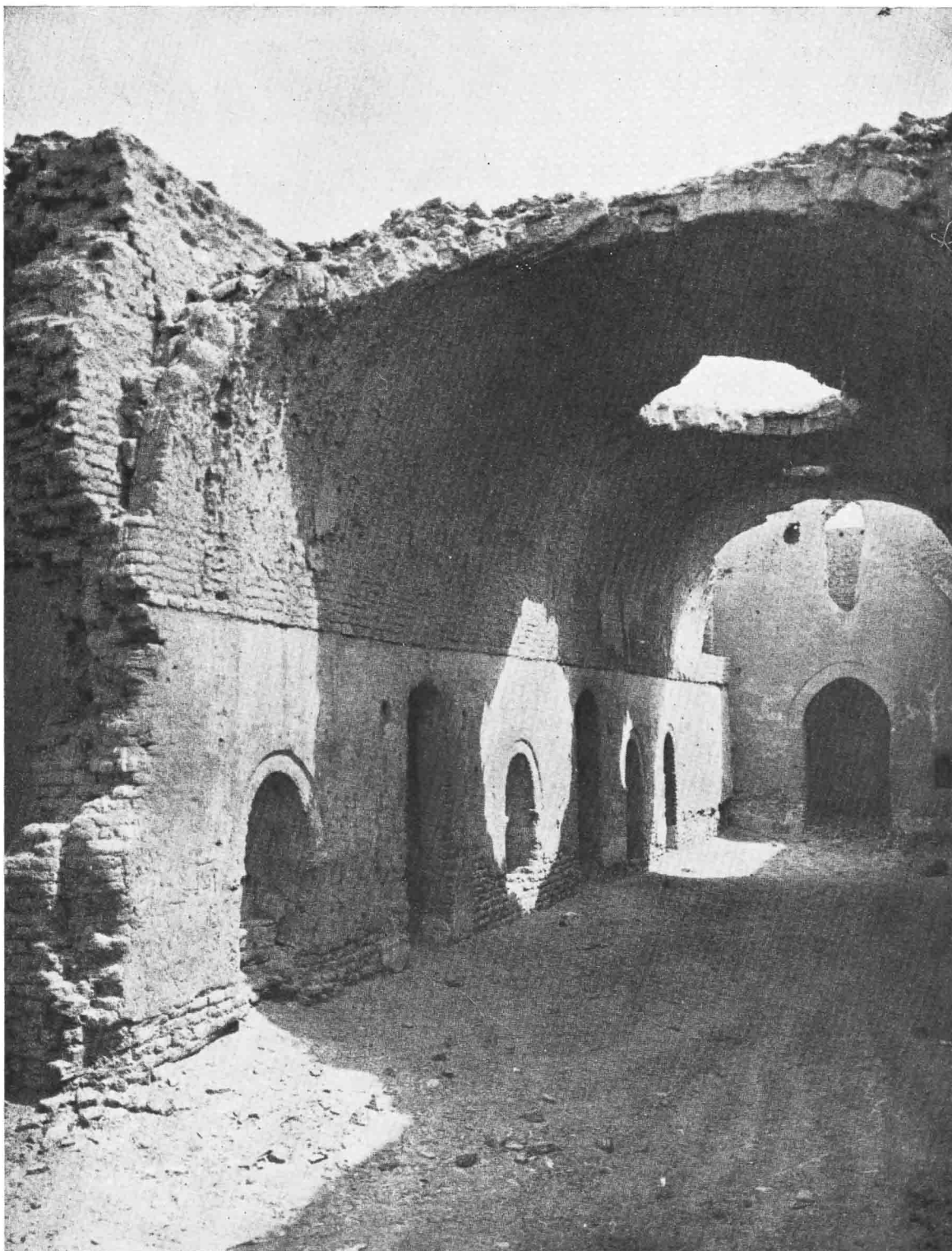
DEIR FAKHOURY : Le couloir central du secteur des cellules.
