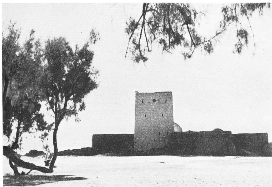
DEIR FAKHOURY, vue prise du nord : l'enceinte intérieure, le donjon et une coupole de l'église.
