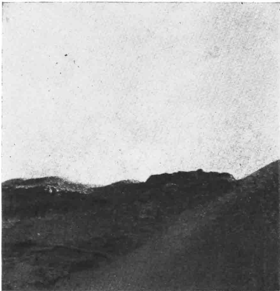
B. — Vue des restes de l'ancien déversoir à déblais.
