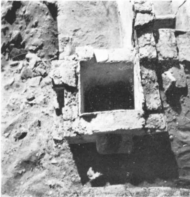
A. Le réservoir (vue plongeante du Nord). On aperçoit, à l'avant, dans la partie sombre, le récepteur ali- mentant la cuve en eau sainte.
