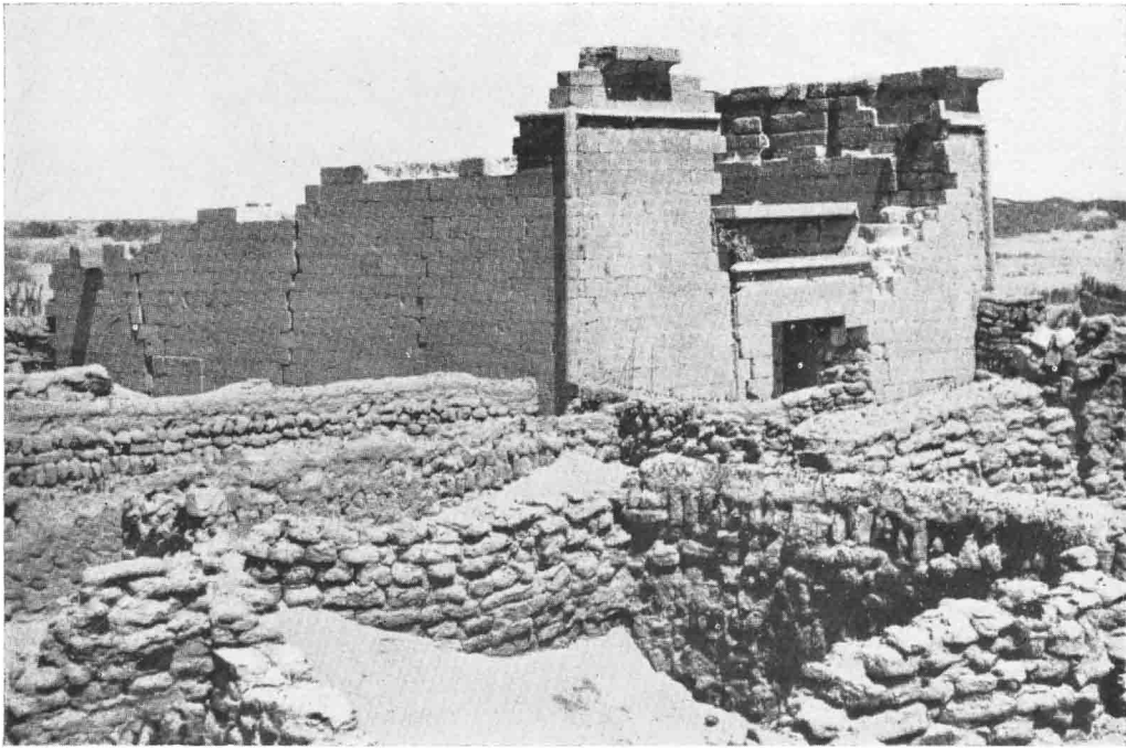
Qasr es-Zayan, vue d'ensemble.
