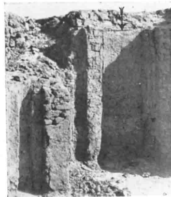
3. L'une des fausses portes de cette tombe montrant encore l'emplacement du rouleau.
