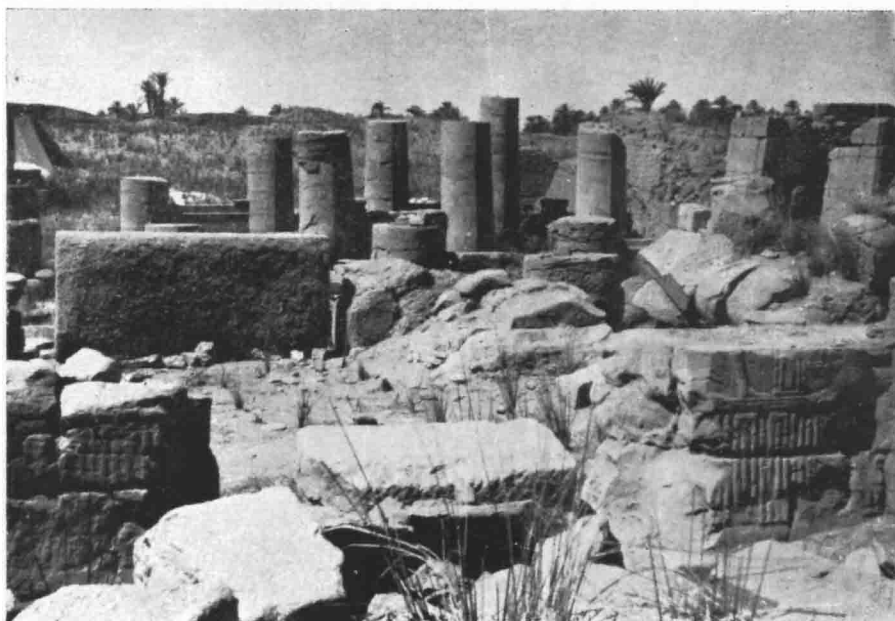
B. La colonnade éthiopienne de l'Est, vue du Nord, de la plate-forme de l'édifice ptolémaïque P.
