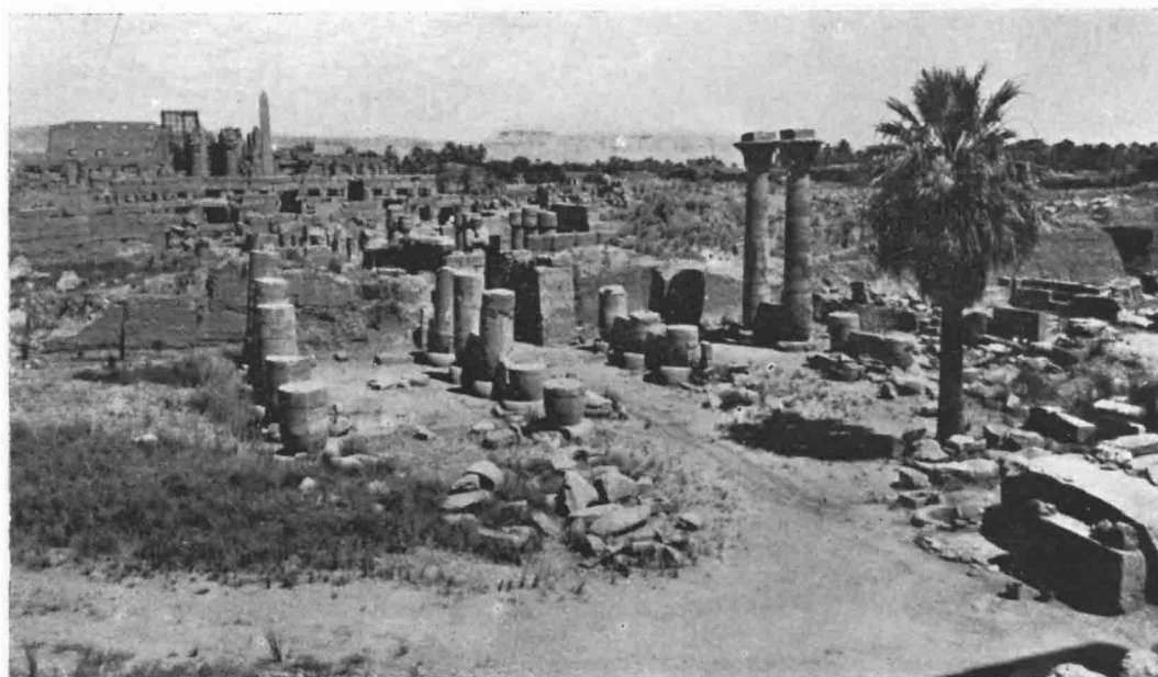
B. Le secteur Est de Karnak, vu de l'Est, après déblaiement et restauration de M. H. Chevrier (printemps 1952) : les colonnes 19 et 20 ont été remontées; à droite, derrière le palmier, plate-forme de l'édifice ptolémaïque P; au fond, le mur de briques du temple de Ramsès II et sa porte de grès, décorée.
