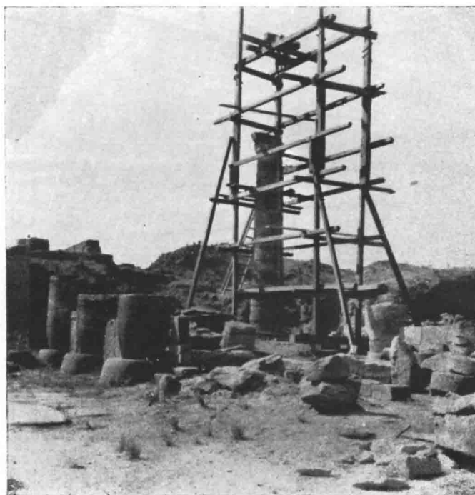
B. Anastylose de la colonne 20 (printemps 1952).
