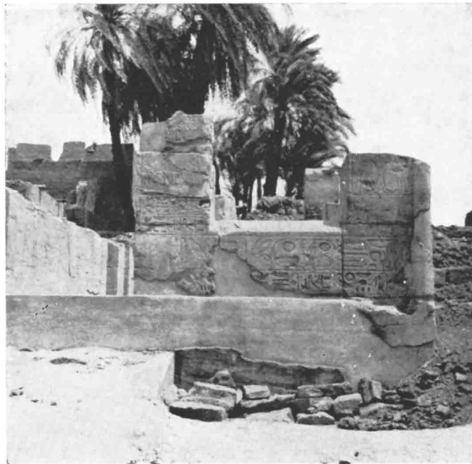
b. — Entrée sud du temple, après sa restauration.
