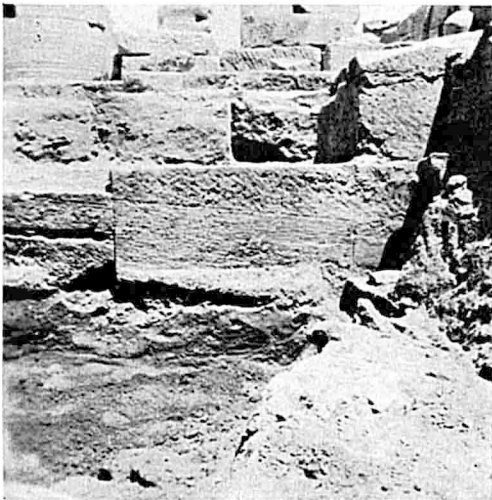
3. Indication par un trait incisé dans le massif nord de la cour du tracé définitif de la rampe.
