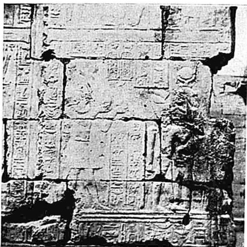
1. Revêtement d'or à l'entrée du sanctuaire. Côté droit (sud), 1 er registre.
