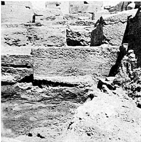
3. Indication par un trait incisé dans le massif nord de la cour du tracé définitif de la rampe.
