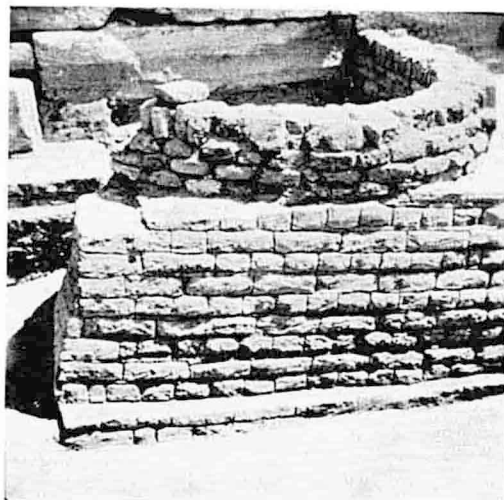
2. Angle nord-ouest. On voit qu'il a été détruit sur la face nord (côté gauche de la photo) par les fondations de la basilique copte. Remarquer au niveau du sol actuel, la construction circulaire en briques cuites.
