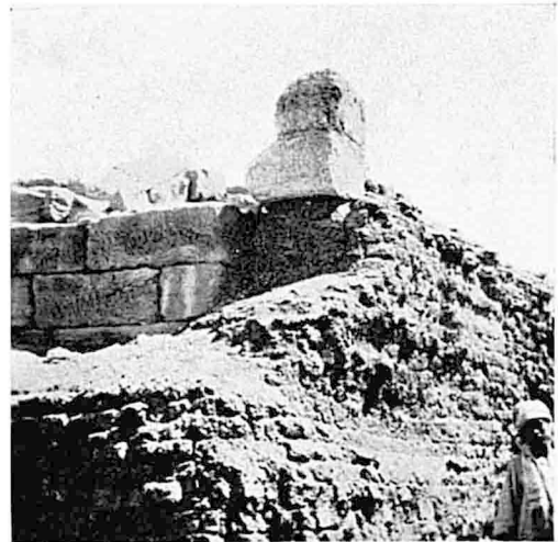
2. Le mur de briques de Nectanébo. Angle sud-ouest. On voit à l'intérieur le mur d'applique ptolémaïque de l'escalier et deux blocs de calcaire du couronnement du mur de briques.
