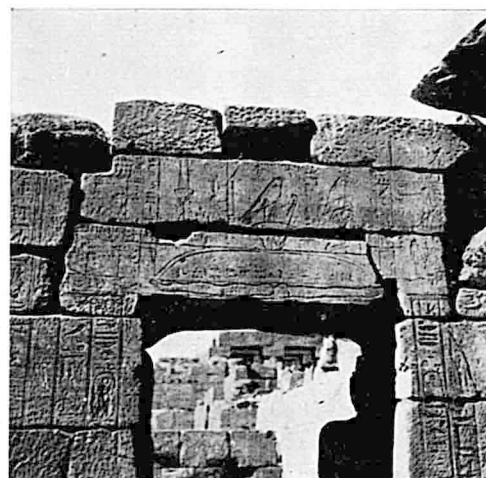
D. — Édifice du Lac; salle IV, porte de la paroi Ouest. Le disque solaire des cartouches a été respecté.
