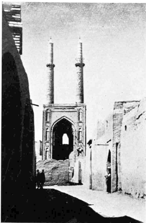
3. — Grand portail, vue d'ensemble.
